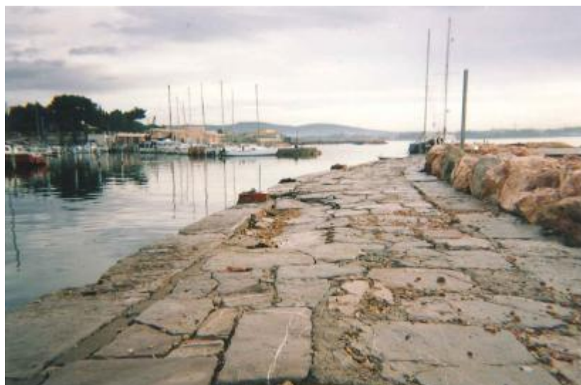
Port départemental – Bassin de plaisance Dommages à la digue Ouest en maçonnerie
