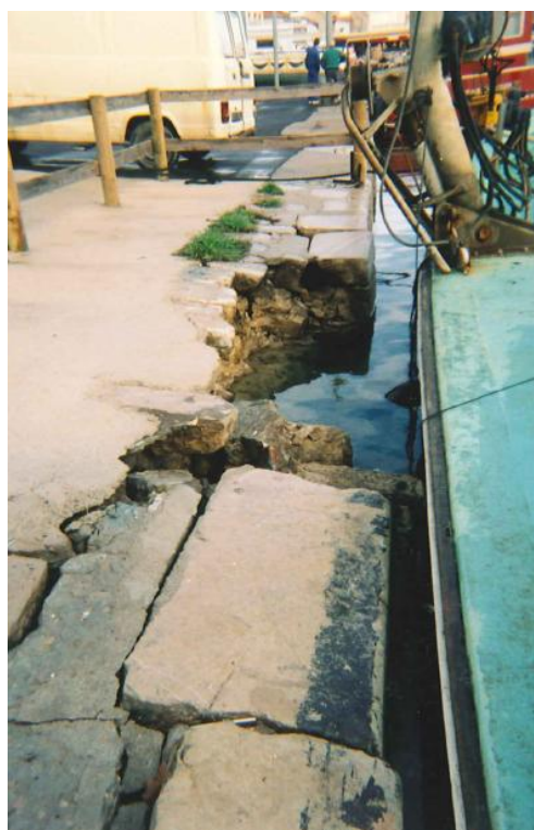
Port départemental – Bassin de plaisance Dommages à la digue Ouest en maçonnerie
