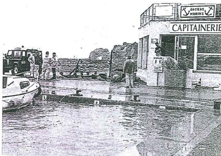
Banyuls-sur-Mer : "C'est une marée bretonne !" La mer est montée de plus d'un mètre, envahissant les quais devant la capitainerie.
