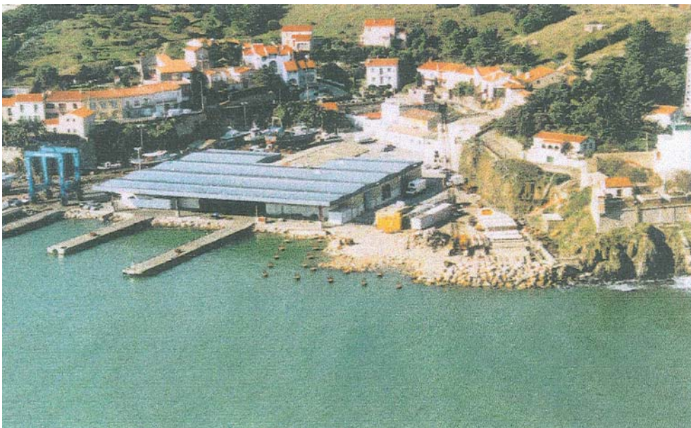
Chantier de l'anse Gerbal
