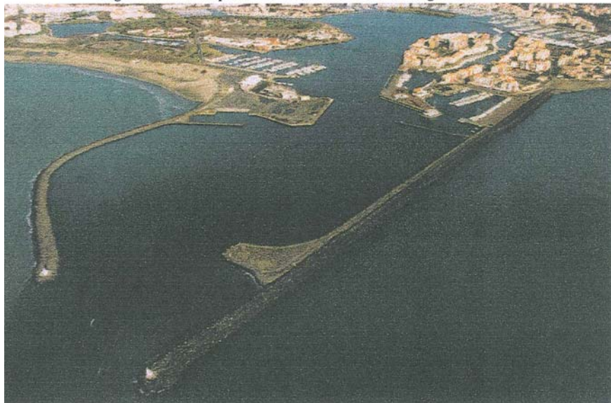
Dégradations multiples du talus et du musoir de la digue EST
