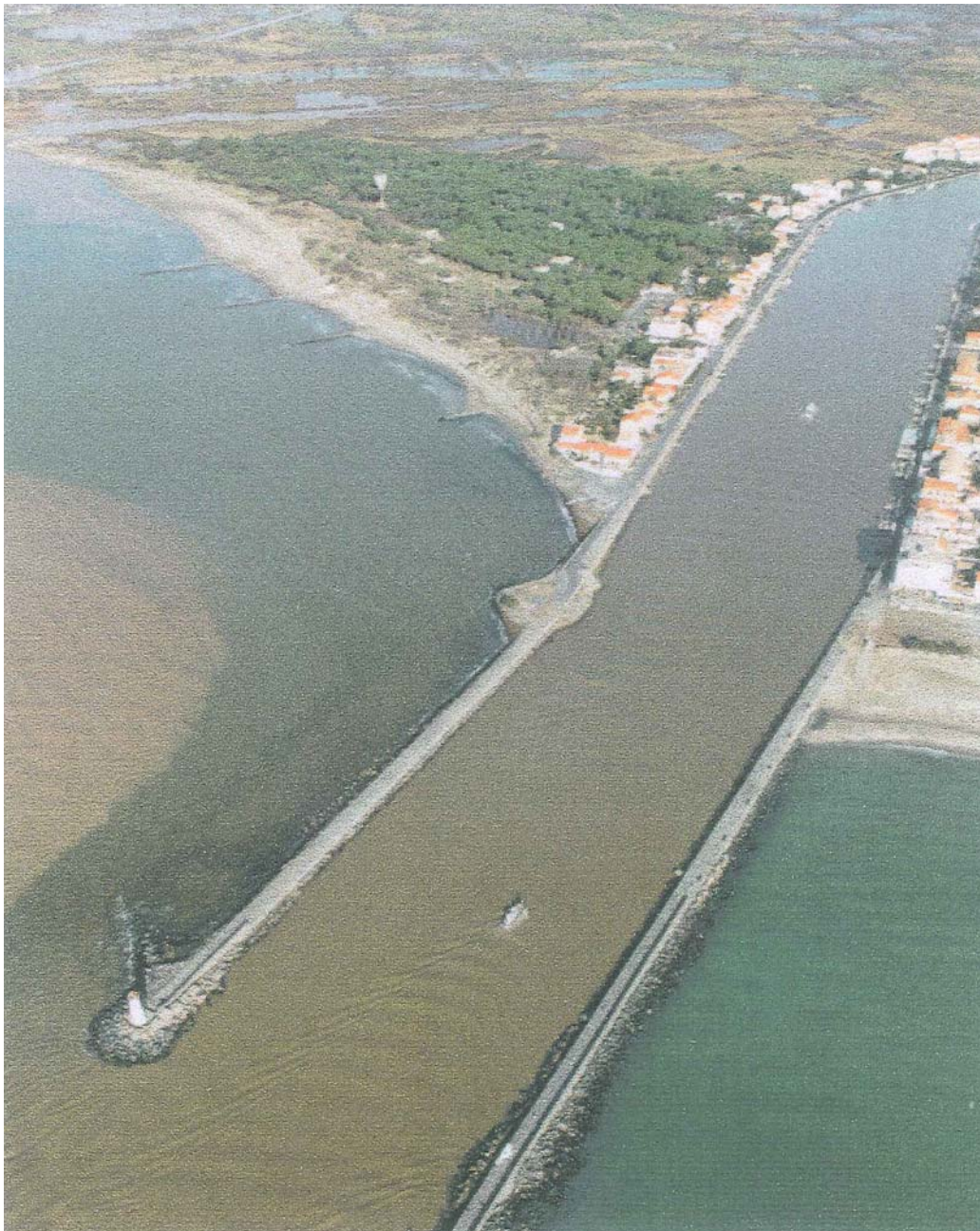
La Tamarissière « Zone Est » Dégradation du cordon dunaire et dégraissement de la plage.
