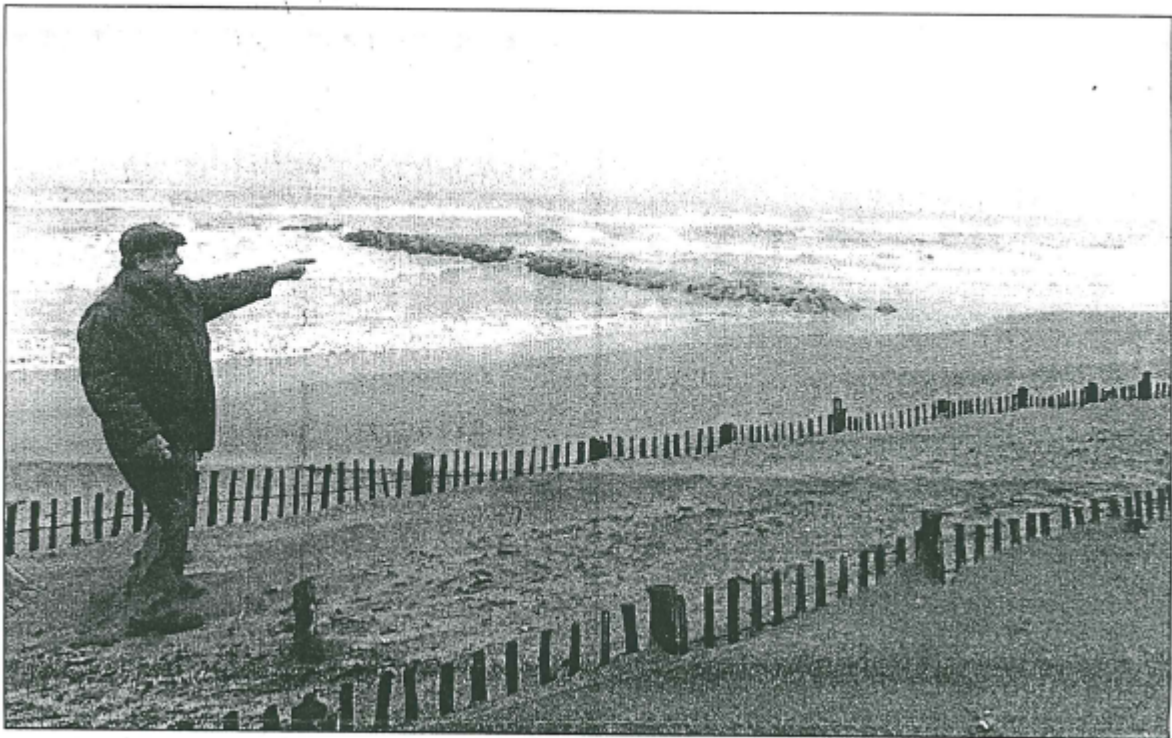
André Della Santina, conseiller municipal du Grau-du-Roi délégué à l'environnement. Au droit des épis, les dunes sont intactes.
