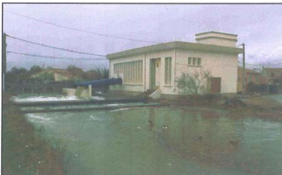
Photographie 14 - Station de pompage
