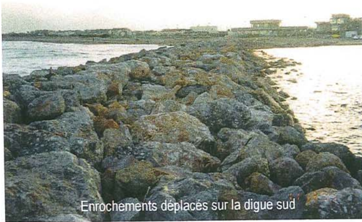
Talus de protection de la plage sud endommagé
