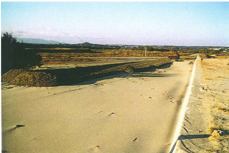
Vu du sable déposé sur le terre-plein ; son épaisseur atteint 80 cm.
