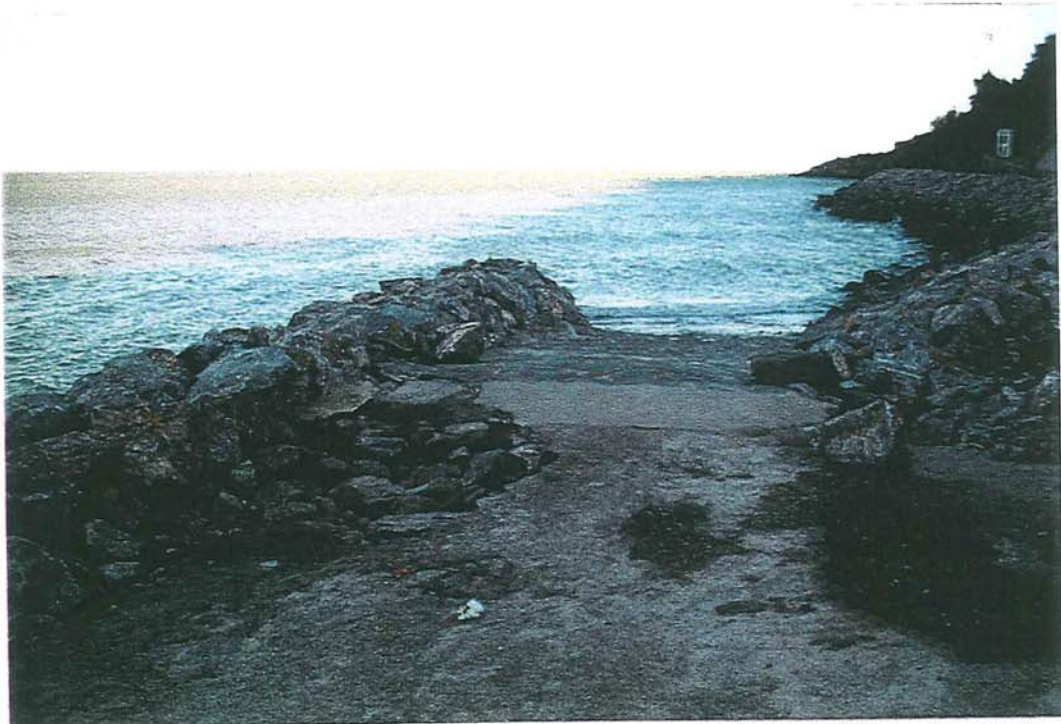
Photo n° 9 - La rampe et le talus avoisinant sont en parfait état ; seul le revêtement à l'arrière a souffert.
