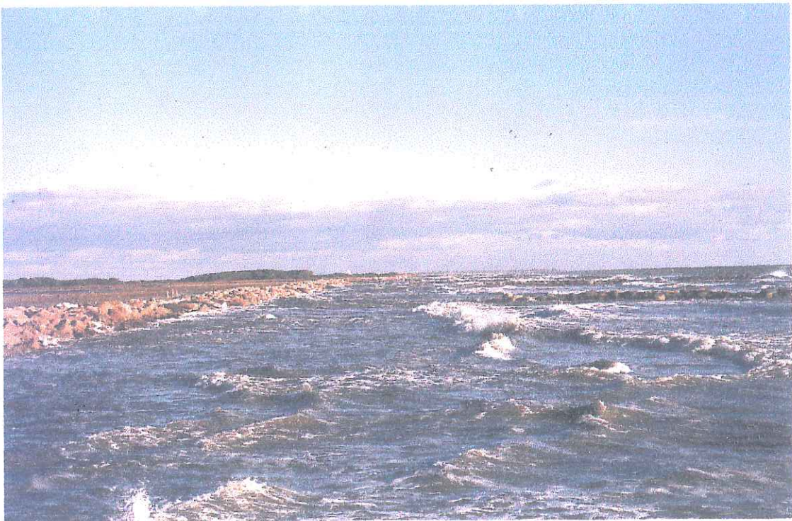
Disposition de la plage - affaissement général de la digue frontale -
