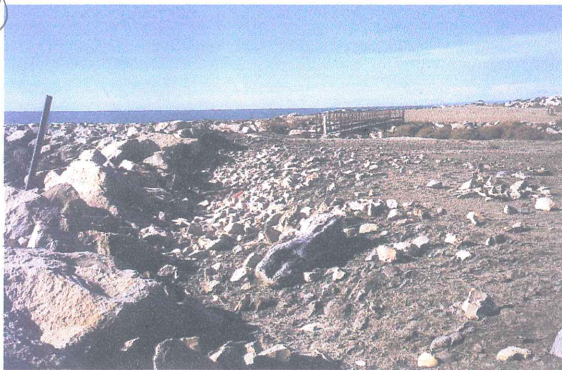
Franchissement de la digue frontale à la prise 1
