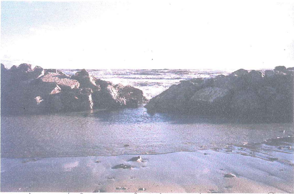
Breche de de la digue frontale - Sédiments du grand Radeau.
