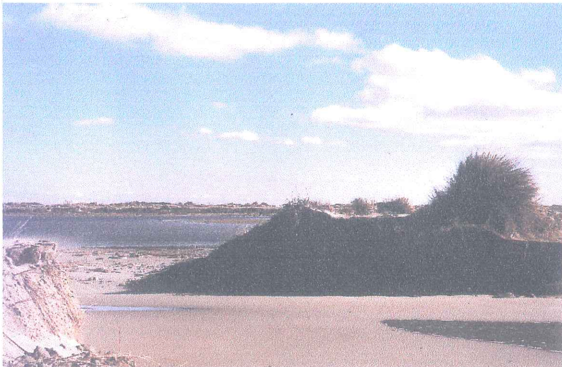
Breche dans la protection frontale.
