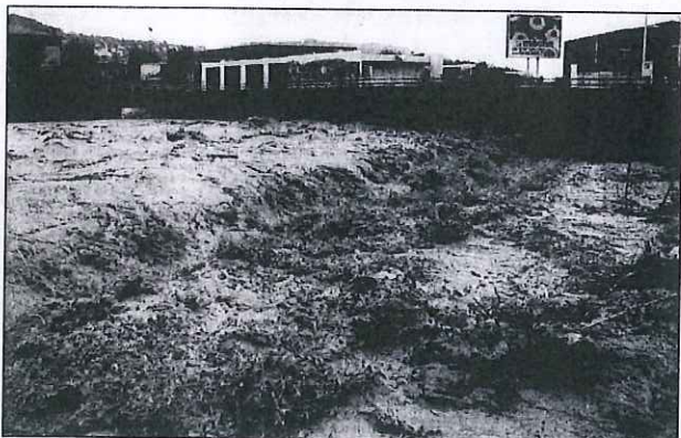
Le paillon arrive à hauteur du tablier du pont Vincent-Auriol. A droite de notre cliché, le lycée Guillaume-Apollinaire a dû être évacué hier par mesure de sécurité.
