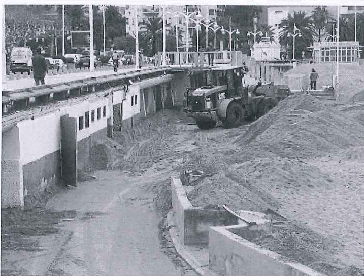
Tôt hier matin, les engins de chantier ont pris possession de la plage du Veillat. Photo M. V.
