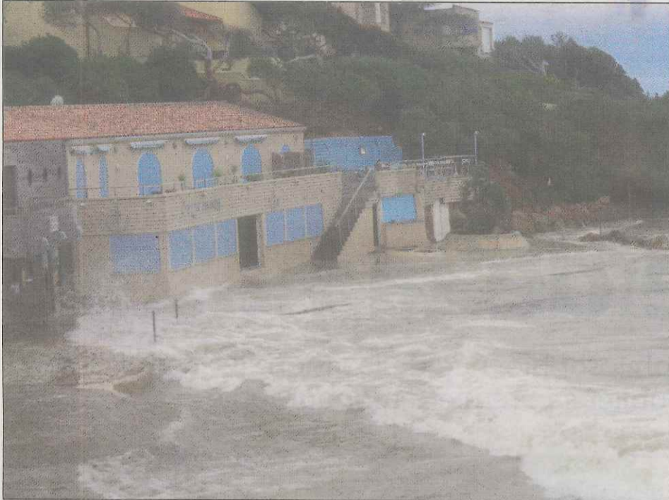
Le restaurant O Petit Monde, sur la plage de Portissol, paie un lourd tribut : l'eau s'est engouffrée à l'intérieur de l'établissement, cassant notamment une porte et emportant une partie du mobilier. (Photo A. B.)
