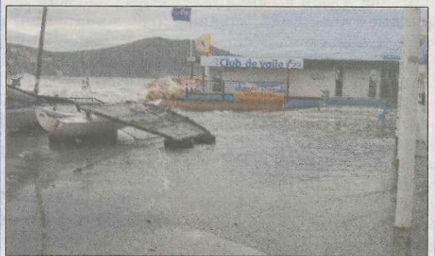
Le club de voile situé aux Lecques n'a pas été épargné non plus. Plusieurs bateaux ont été endommagés.
